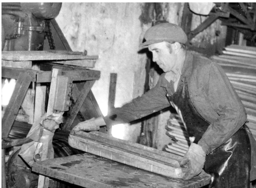
Озерновский РКЗ: подготовка оборудования для холодильника
